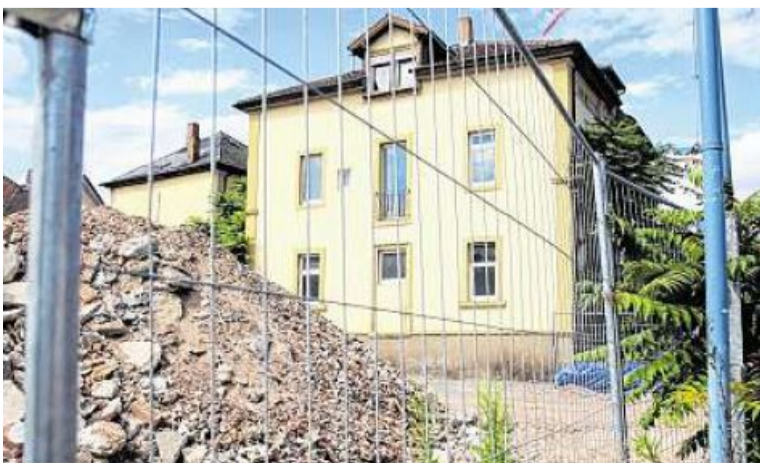
Noch ist es eine Baustelle, doch im Frühjahr 2020 soll hier ein neuer Wohnkomplex entstehen.
