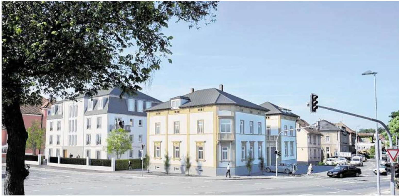
Die markante Kitzinger Schmiedel-Villa wird saniert und zu einem Wohn- und Bürogebäude umgebaut. Links daneben entsteht ein Neubau in ähnlichem Stil. FOTO: VISUALISIERUNG: ROSENTRITT WOHNBAU GMBH
